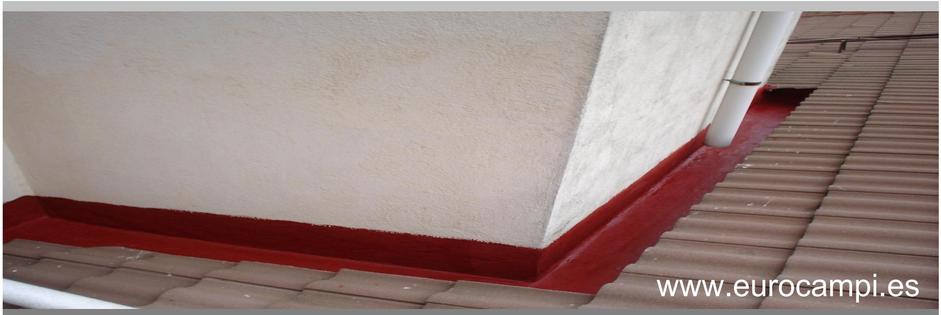
Recubrimiento impermeabilizante autoarmado **al agua**
